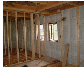
2010/00/00 床、内壁耐熱材貼り 壁の内側はこうなっています！
