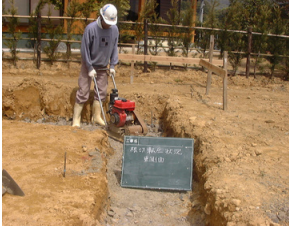
2010/00/00 根切転圧状況
