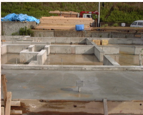
2010/00/00 基礎工事完了 どこがどのお部屋になっているか、おわかりになりますか？
