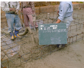
2010/00/00 コンクリート打設
